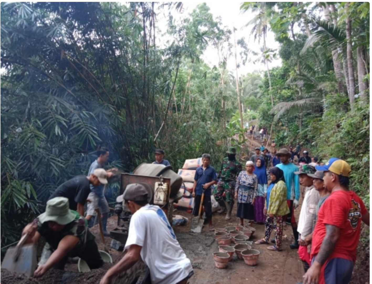
Babinsa Koramil 22/Ayah Serma Tugino bersama warga Giyanti bahu membahu membangun talud penahan bahu jalan
