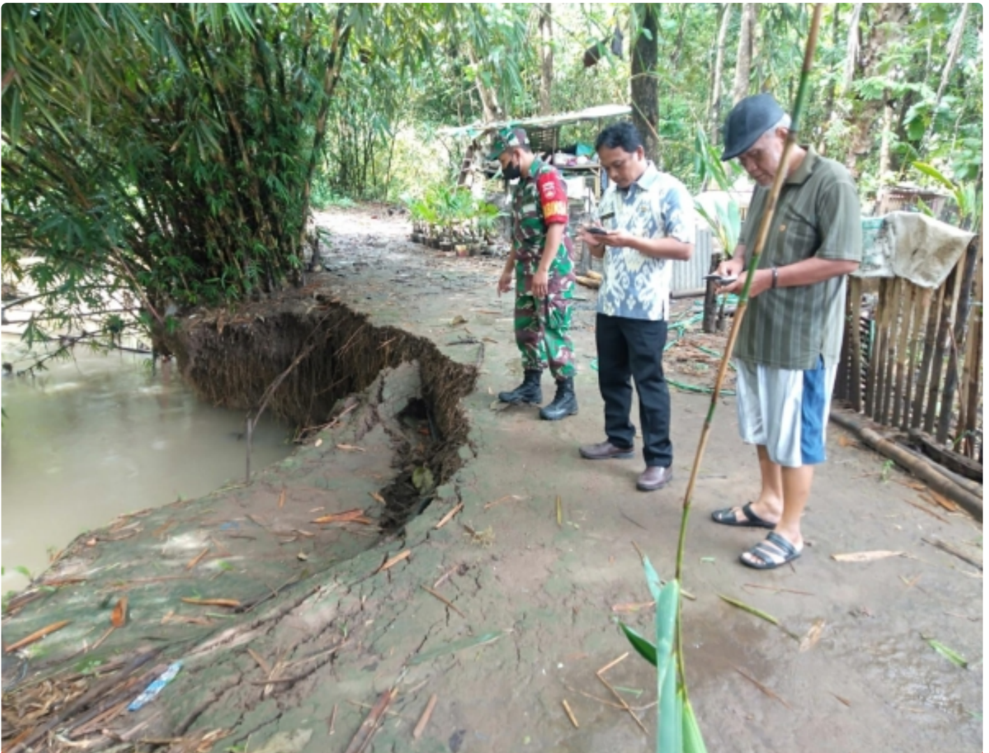
Serda Nur Arifin cek Lokasi tanggul sungai Sirago Amblas di wilayah Dusun Ingas RT 02/05 Desa Sruweng
